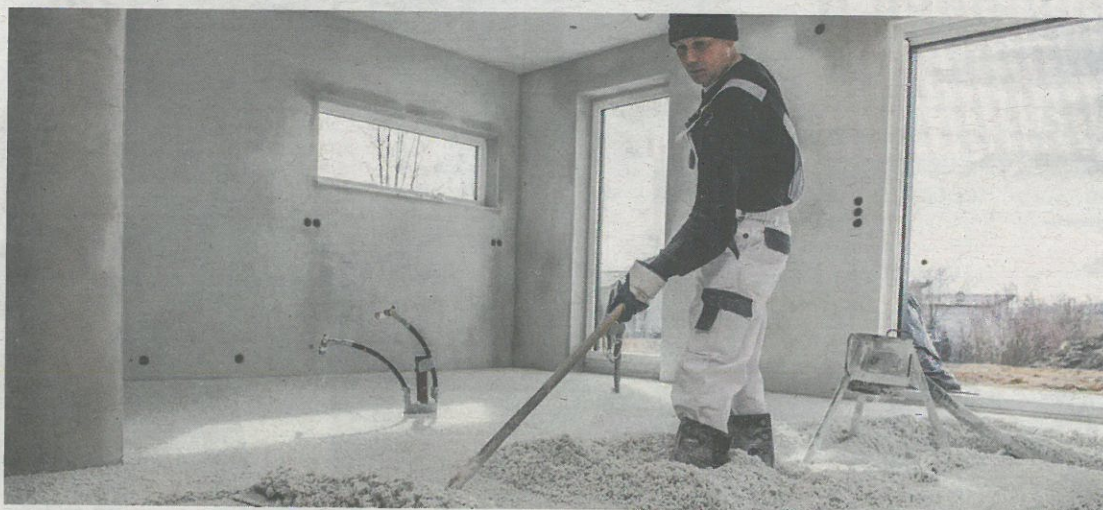
Mittels Schlauchleitung wird das Granulat direkt in den Wohnbereich transportiert.
